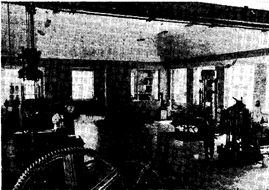
Vista Panorámica de la Sala de Máquinas del IDIEM.
