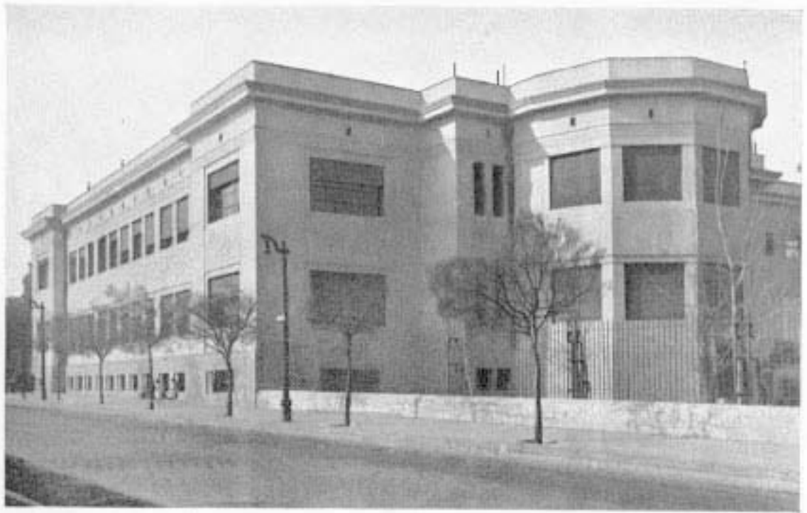
Escuela de Arquitectura. Fachada lateral y posterior.
