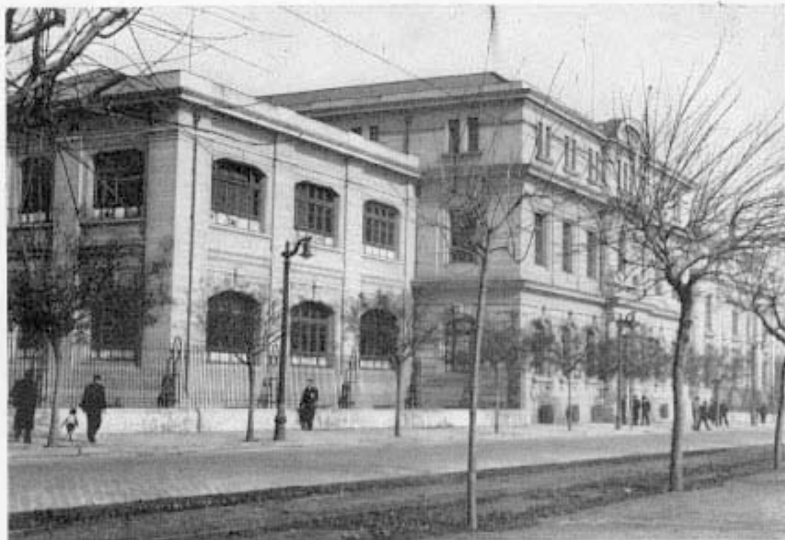
Escuela de Ingeniería. Pabellón de Física y Electrotecnia.
